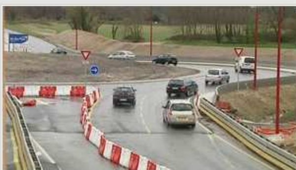
Le chantier du Taillan-Médoc (33) doit permettre de réduire le CO2
